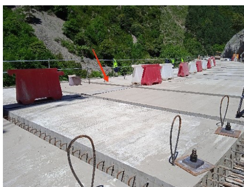
Figura 10. Puesta en obra de las placas prefabricadas de los voladizos.
