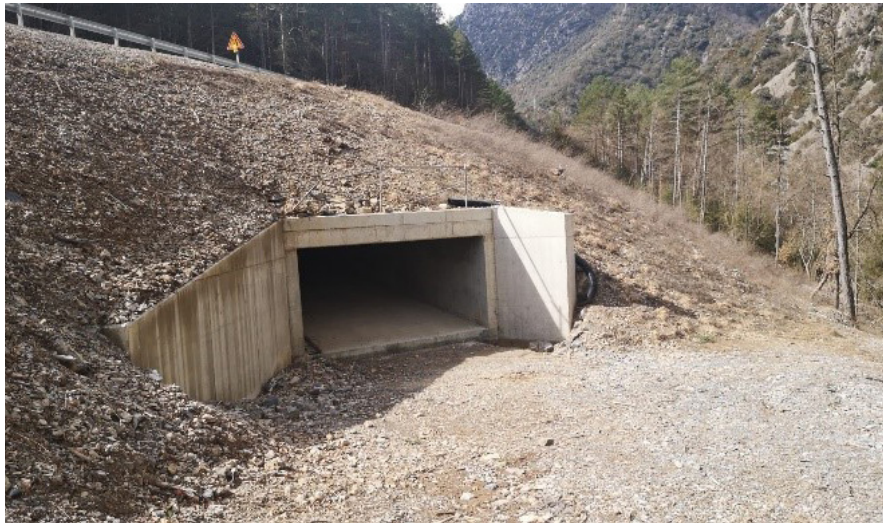
Figura 14. Paso de fauna
