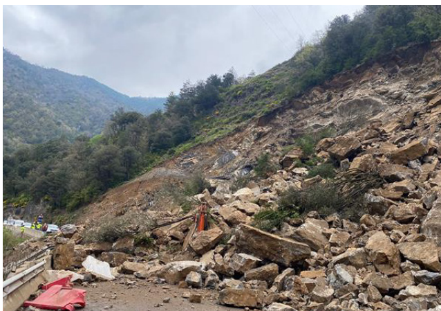
Figura 16. Imagen del deslizamiento y sus consecuencias
