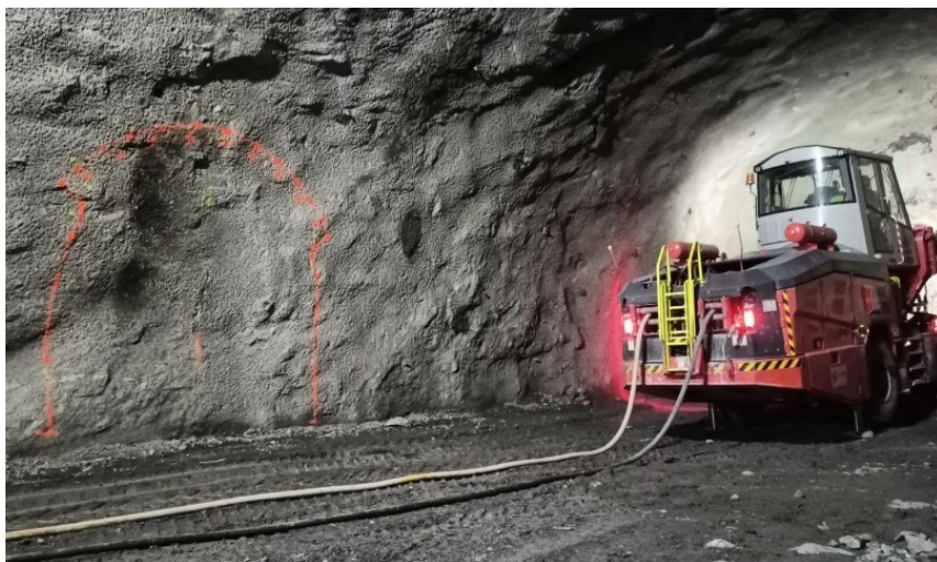
Figura 13. Replanteo de la galería de evacuación
