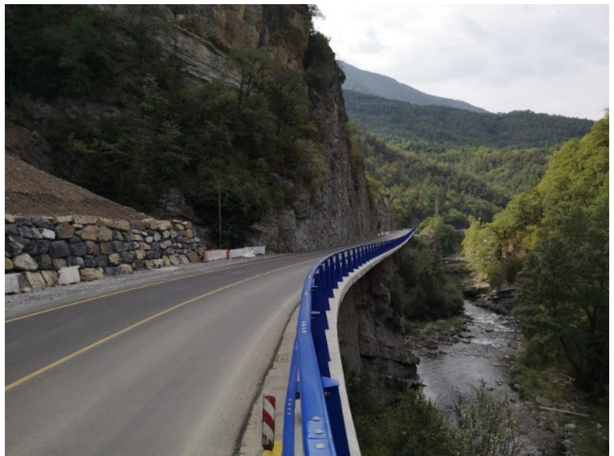
Figura 23. Tramo actual ya prácticamente acondicionado.
