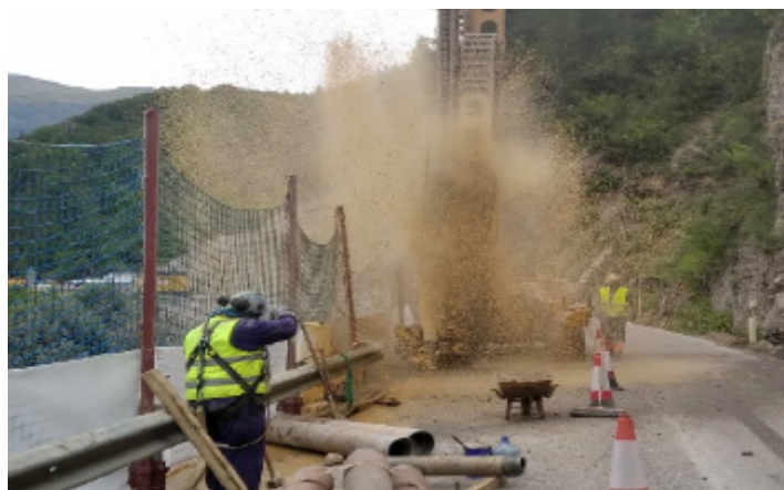
Figura 9. Perforación de micropilotes. Durante el proceso se producen salpicaduras que afectan al tráfico
