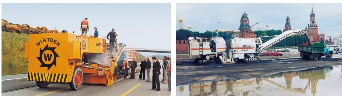
Figura 13: Fresadoras en frío. Carga trasera (izda) y delantera (dcha)
