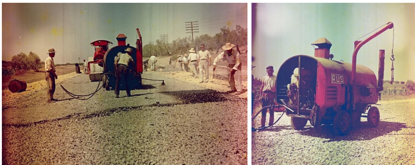
Figura 10. Bituminadoras para la ejecución del riego asfáltico sobre bases granulares 6
