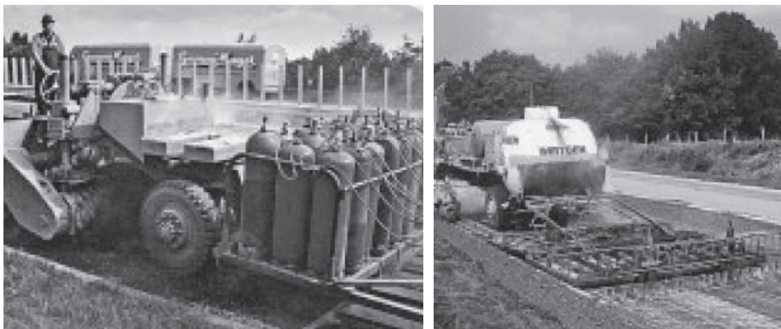
Figura 12: Primeras fresadoras en caliente. 1971 (izda) y 1973 (dcha)
