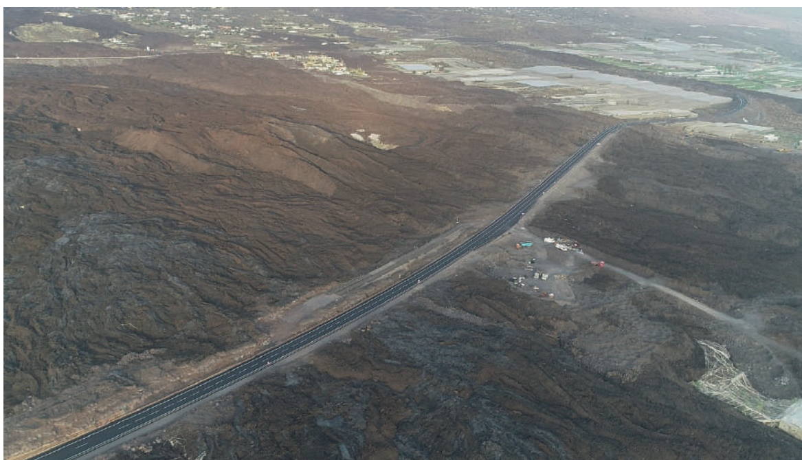
Figura 17. Vista aérea del tramo de pruebas
