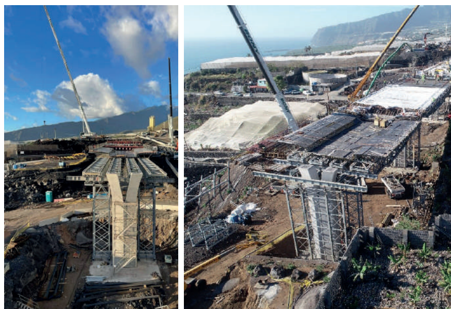
Figura 16. Fases de construcción del viaducto
