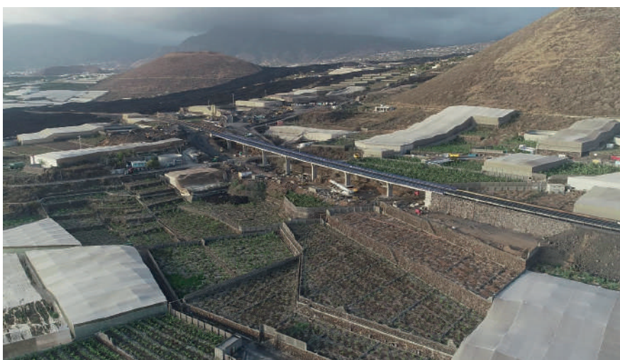
Figura 13. Vista general del viaducto
