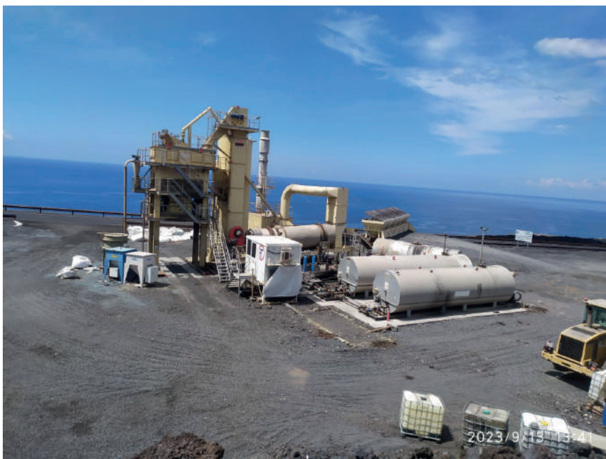
Figura 12. Planta asfáltica discontinua de tipo modular
