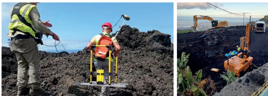
Figura 8. Trabajos de reconocimiento geotécnico
