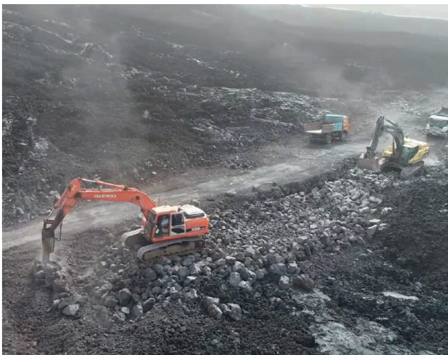
Figura 11. Trabajos de excavación en lava
