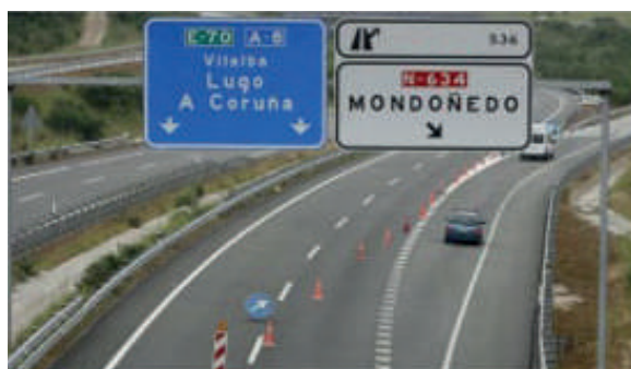
Figura 4. Desvío manual mediante señalización física de carriles en la A-8
