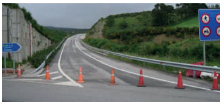
Figura 5. Desvío manual mediante señalización física en acceso a A-8.
