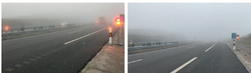
Figura 11. Balizas detectoras en condiciones de baja visibilidad. Autovía A-8. Alto de O Fiouco (Lugo)
