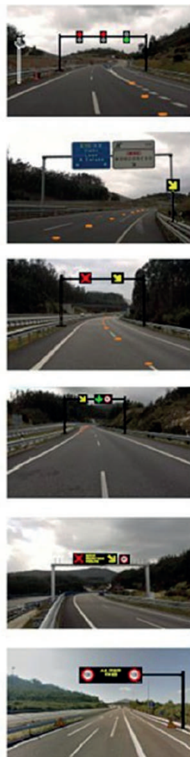
Figura 6. Detalle del esquema del equipamiento instalado en el tramo afectado de la A-8 y su funcionamiento
