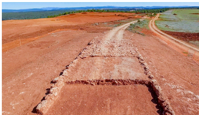
Capas del firme de la calzada romana de Numancia a Uxama.
