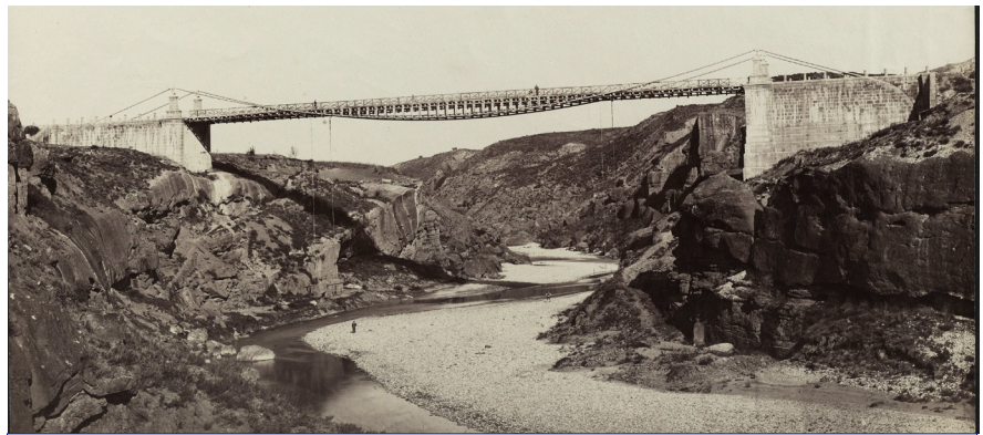
Figura 13. Puente de Lascellas (Huesca). Fotografía de José Martínez Sánchez (a. 1867).
