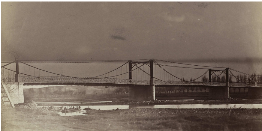
Figura 5. Tercer puente de Arganda (1867), con columnas de hierro laminado. Fotografía de José Martínez Sánchez.
