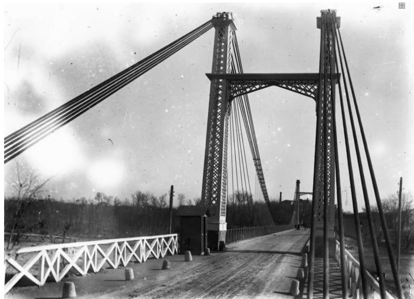
Figura 9. Puente colgante sobre el Gállego en Zaragoza, después de su reforma de 1889-1890.
