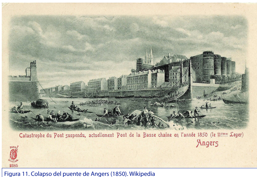
Figura 11. Colapso del puente de Angers (1850). Wikipedia
