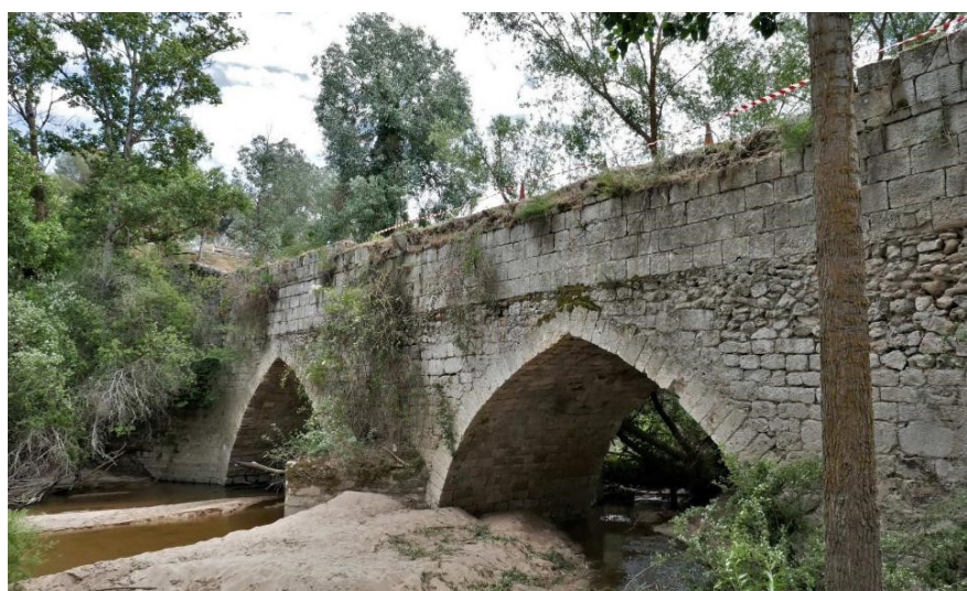
Figura 7. Distintas fábricas históricas en el alzado aguas abajo
