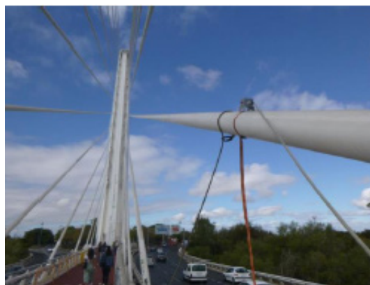
Figura 15. Ejecución ensayo "cuerda vibrante". DMT GmbH & Co. KG. 2.019
