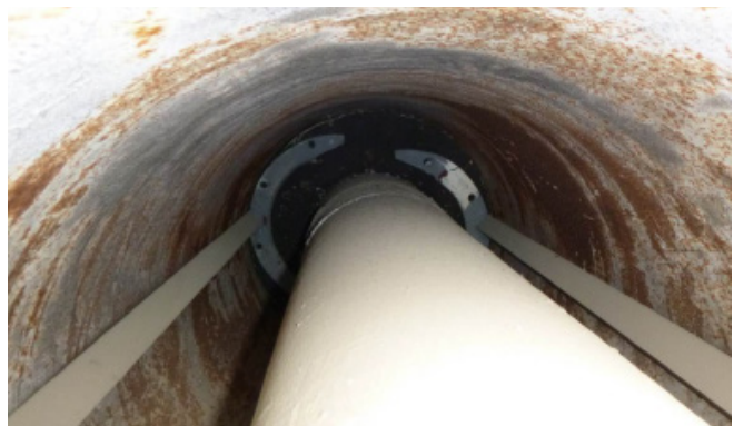
Figura 12. Recolocación anillo centrador. Anclaje Superior. Alpin .2019.
