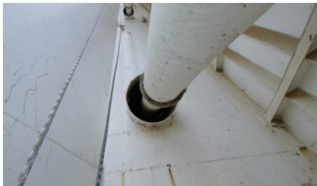
Figura 11. Tubos encofrado paso tirantes. Anclajes superiores. Alpin 2.019
