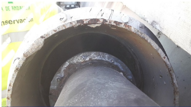
Figura 9. Interior tubo anclaje inferior. IMESAPI 2.019
