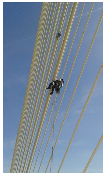
Figura 7. Trabajos en altura. IMESAPI 2.019
