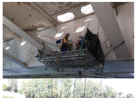
Figura 14. Trabajos verticales sobre el Rio. Alpin 2.019
