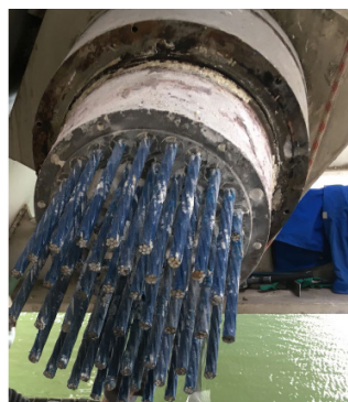
Figura 13. Anclaje inferior tras retirada de capot y lechada de protección. Alpin Technik Leipzig. 2.019
