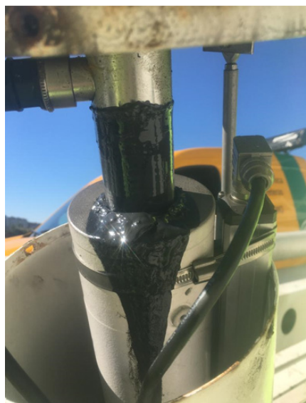
Figura 20. Amortiguador dinámico dañado. IMESAPI 2.021
