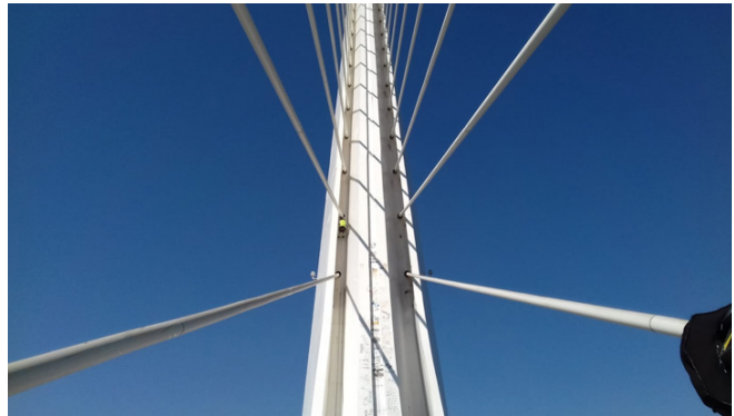
Figura 10. Cara interior de pilono: tubos encofrado paso tirantes. IMESAPI 2.019
