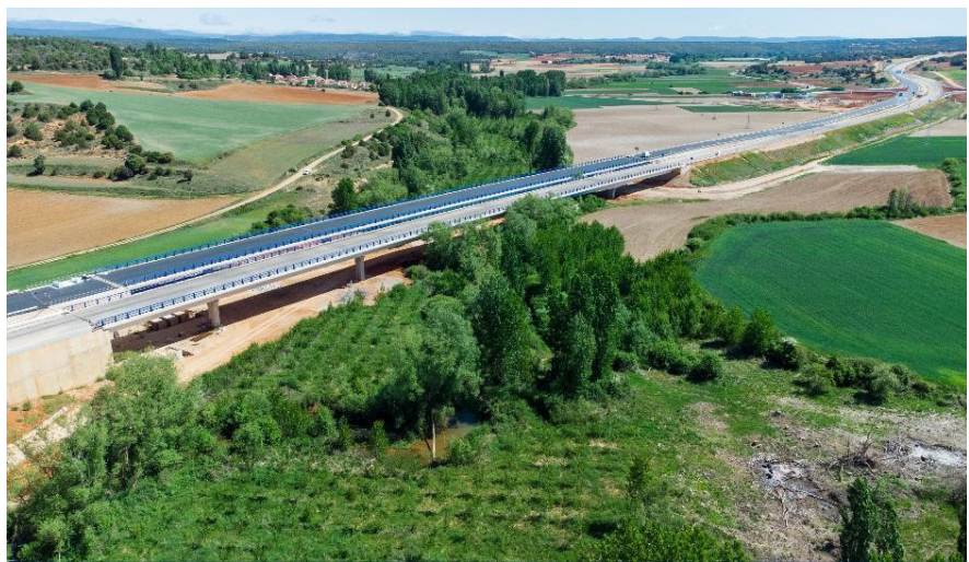
Viaducto sobre el río Abión
