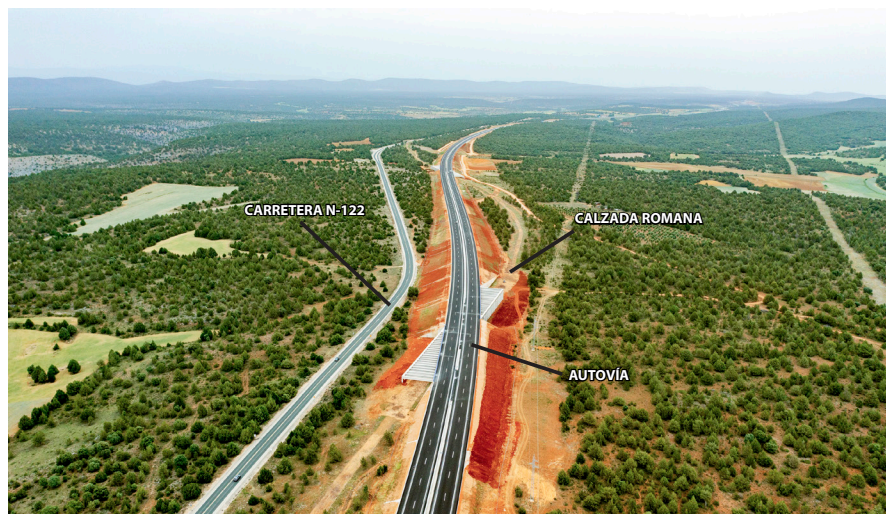
Pérgolas para la desafección de la Vía Romana
