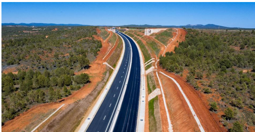
Trinchera de subida al páramo de Calatañazor
