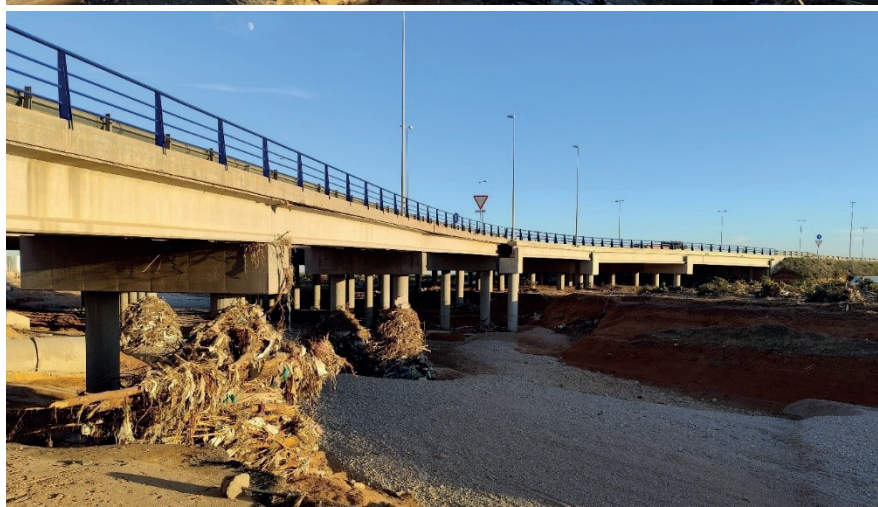
Desmoronamiento de varios tramos de la escollera de protección del talud de separación entre del Barranco del Poyo y la autovía A-3, a la altura de su p.k. 339+300 y erosión del lecho del Barranco del Poyo bajo la estructura de paso de la autovía A-7, a la altura de su p.k. 336+200, con socavación de los encepados de cimentación de las pilas del viaducto.
