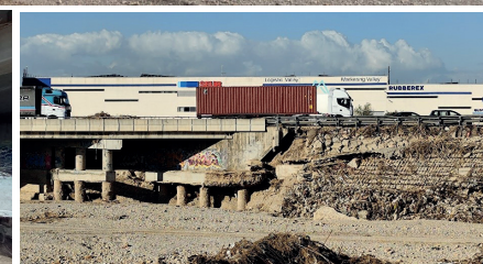
Daños en la estructura de paso de la autovía A-3 sobre el barranco del Poyo: erosión del lecho del cauce y descalce de las cimentaciones de las pilas y de los estribos, desaparición de la escollera revestida de hormigón de protección contra la erosión de los cajeros del cauce en sus entronques con los estribos de la estructura, pérdida de funcionalidad del pretil.
