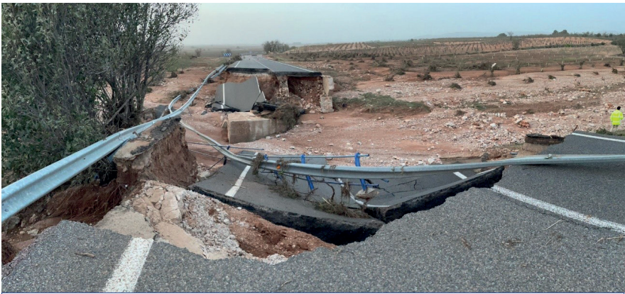
Paso de la N-330 sobre un cauce afluente de la Rambla de la Torre, en Utiel (p.k. 194)
