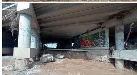
Daños en la estructura de paso de la autovía A-3 sobre el barranco del Poyo: erosión del lecho del cauce y descalce de las cimentaciones de las pilas y de los estribos, desaparición de la escollera revestida de hormigón de protección contra la erosión de los cajeros del cauce en sus entronques con los estribos de la estructura, pérdida de funcionalidad del pretil.
