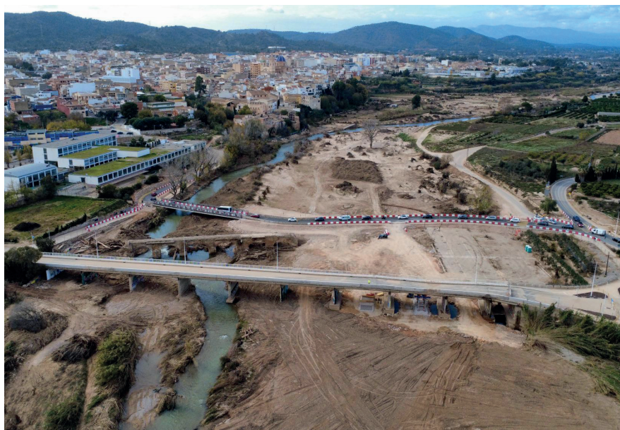
Obras de emergencia, vista de los tres puentes en la carretera CV-336 sobre el río Turia en Ribarroja del Turia
