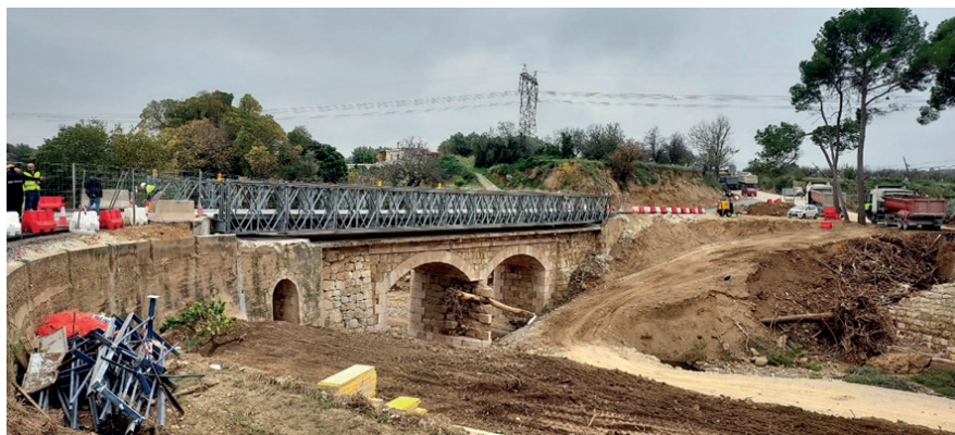
Puente antiguo sobre el río Buñol habilitado como itinerario provisional de la CV-425
