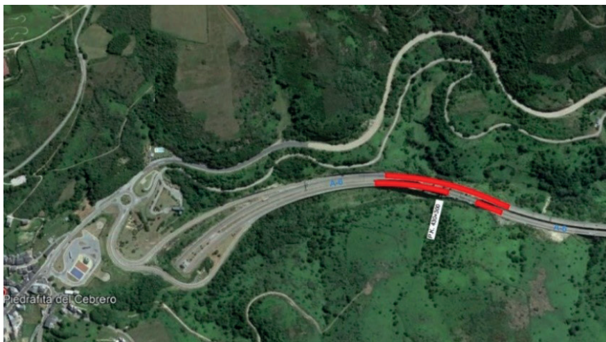
Figura 1. Localización de los viaductos del Castro en la autovía A-6
