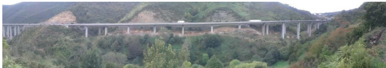
Figura 3. Viaductos del Castro, previamente a las obras de rehabilitación. Calzada derecha sentido A Coruña
