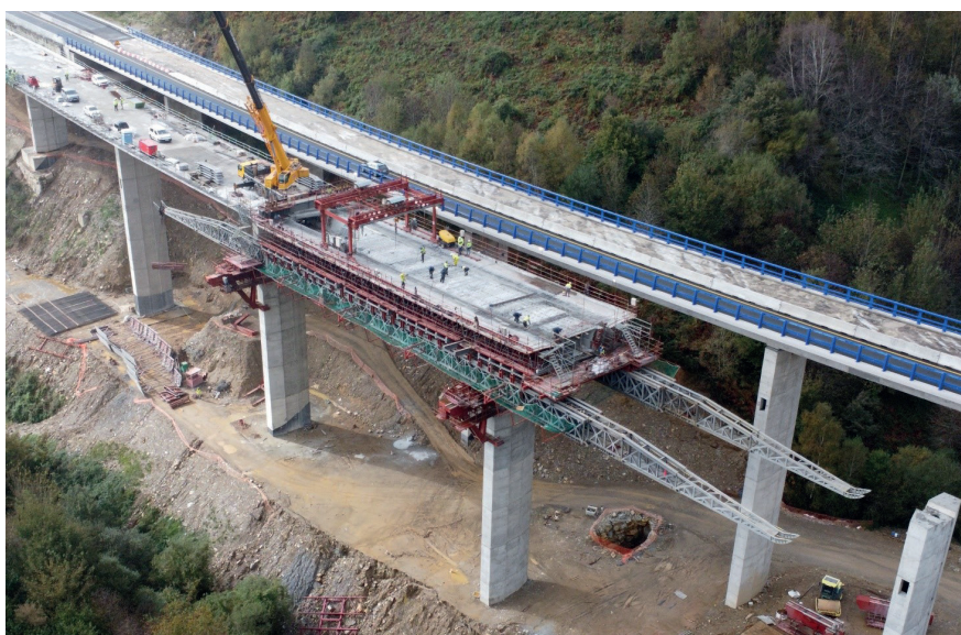
Figura 18. Ejecución del viaducto grande mediante cimbra móvil autolanzable.
