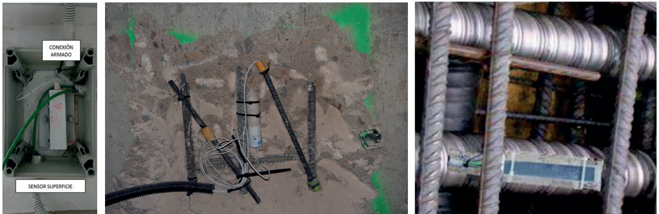
Figura 22. Sensorización de la corrosión en armaduras pasivas preformigonado (izq.), postformigonado (cent.) y de armaduras activas (der).
