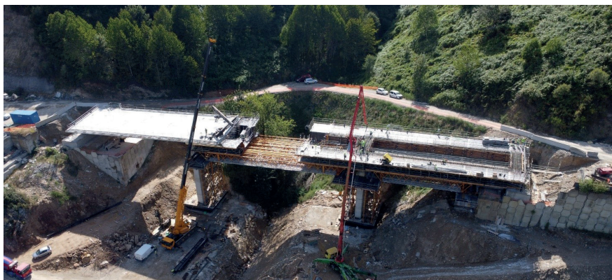
Figura 17. Ejecución del viaducto pequeño mediante cimbra porticada.
