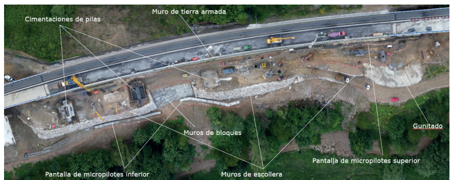
Figura 15. Indicación de elementos construidos para la estabilización de ladera en el entorno del muro de suelo reforzado.
