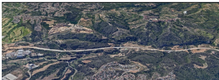
Figura 11. Emplazamiento general de la B-40 en la zona de Viladecavalls (Barcelona)
