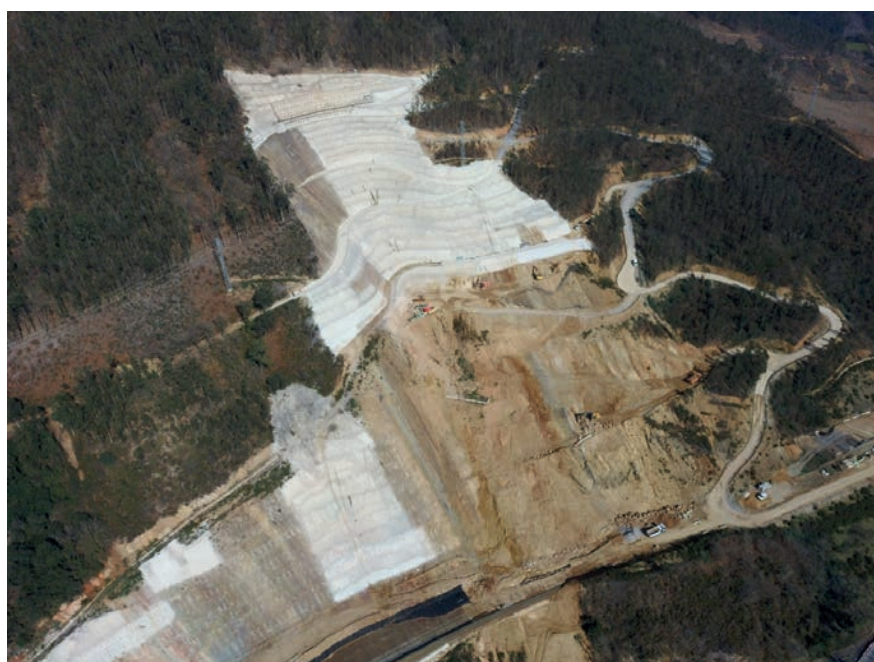
Figura 12. Vista general de las obras de la A-63, en el talud de Casazorrina (Asturias) en febrero de 2025
