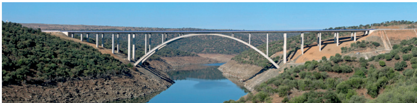
Figura 1. Autovía A 66 Ruta de la Plata. Tramo Hinojal-Cáceres. Viaducto del Almonte. Estructura cuya construcción fue objeto de la primera monitorización en tiempo real en la RCE, en el año 2003
