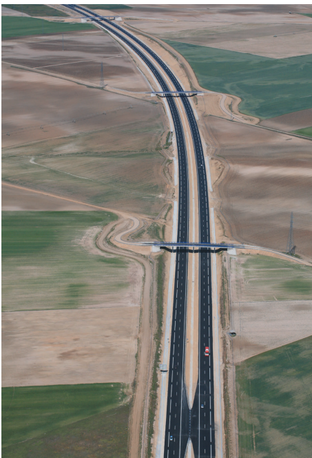
Vistas panorámicas de la obra abierta al tráfico.
