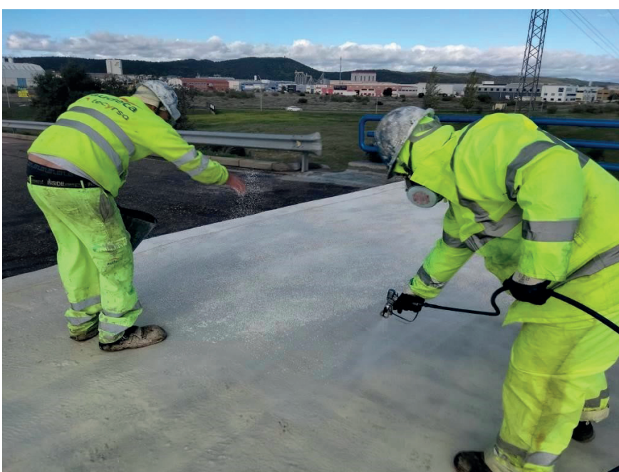
Figura 15. Aplicación de poliureas (capa de acabado, con extendido de pellets)
