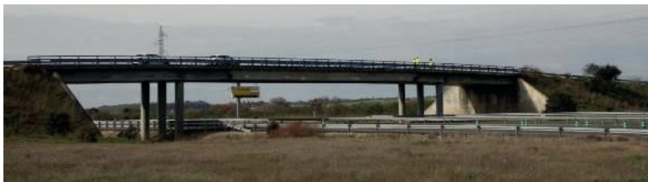
Figura 1. Imagen del alzado este de la estructura antes de la intervención
