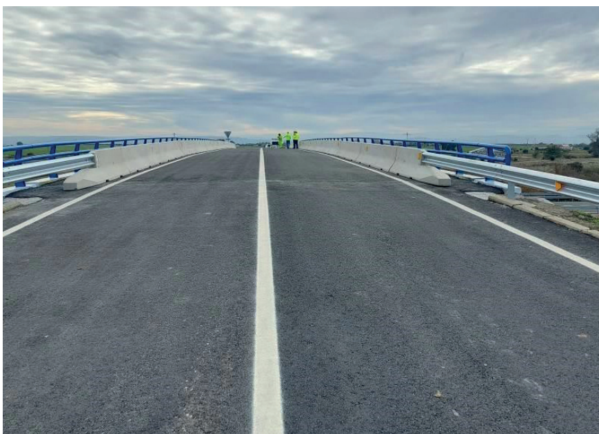
Figura 18. Vista superior del puente tras las actuaciones
