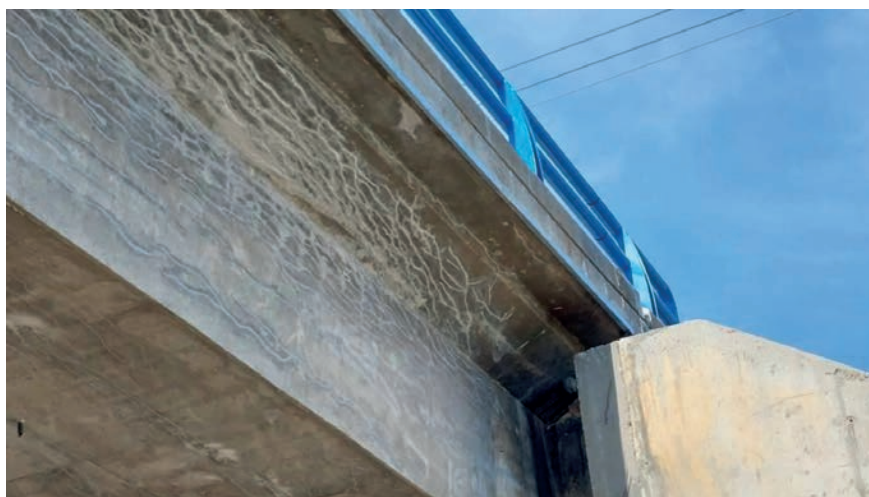
Figura 11. Preparación de fisuras en alma de losa, antes de su sellado o inyección
