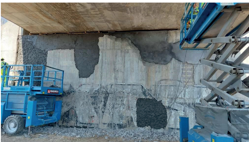
Figura 12. Reparación del paramento de un estribo
