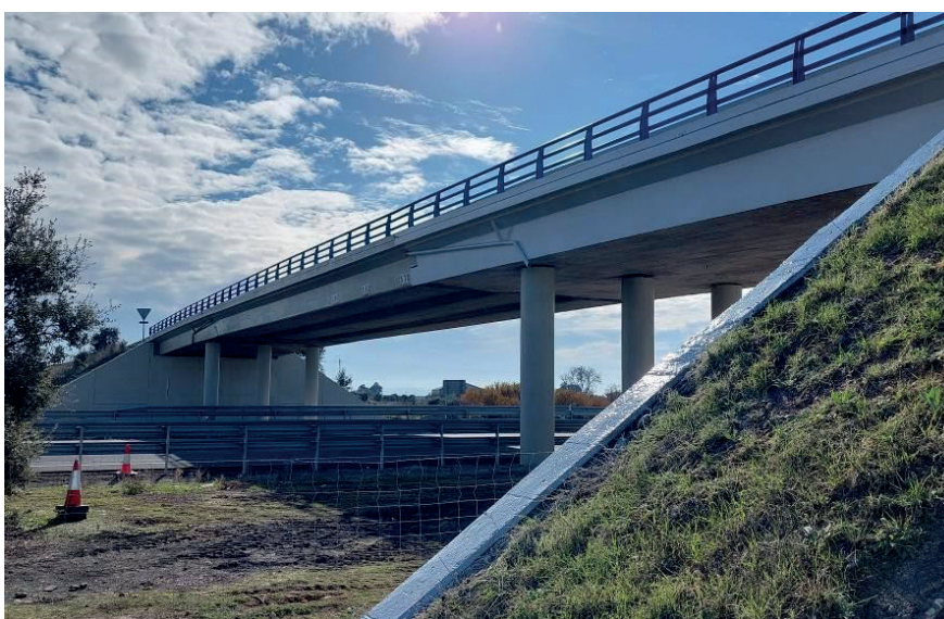
Figura 19. Alzado oeste del puente tras las actuaciones
