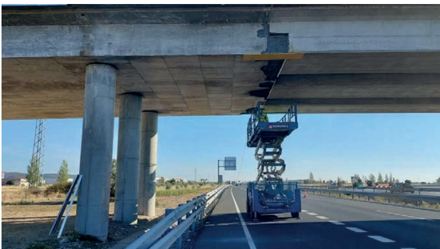
Figura 13. Reparación del apoyo a media madera
