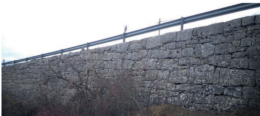
Figura 12. Muro de sillería en el p. k. 70+360 MD en el páramo de Bricia.
