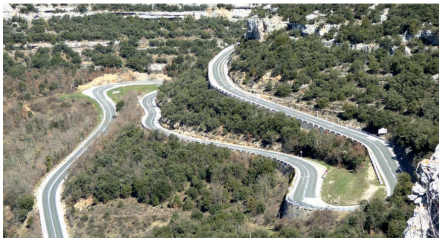
Figura 3. Trazado adaptativo del Alto de Escalada.
