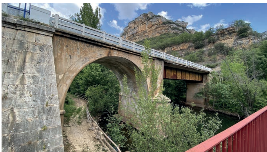
Figura 4. Puente sobre el río Ebro en Quintanilla Escalada.
