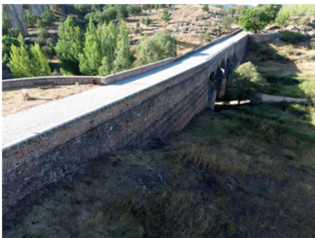
Figura 11. Rehabilitación del puente de piedra sobre el río Golmayo
