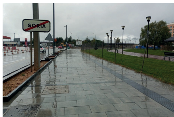
Figura 15. Pavimento en Avenida de Valladolid
