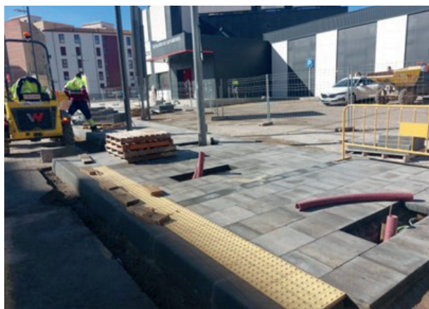
Figura 3. Pavimentación podo-táctil junto a marquesinas de autobús
