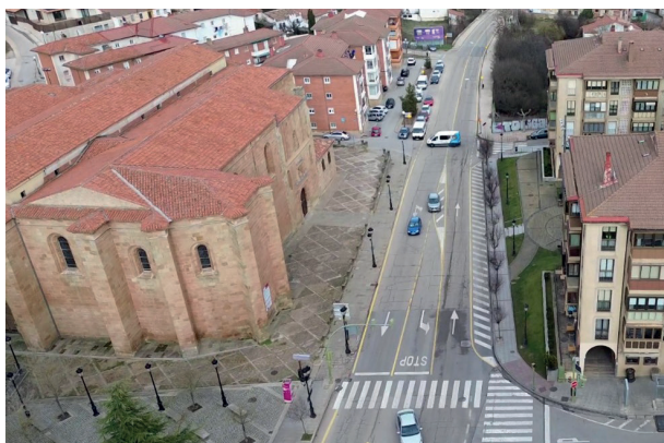
Figura 18. Pavimento de losas de piedra caliza junto a la Concatedral de San Pedro
