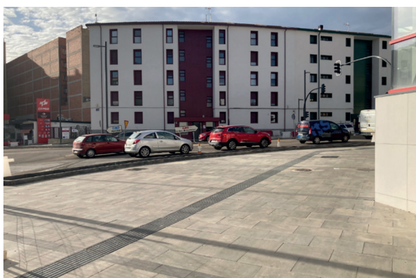
Figura 14. Pavimento en Glorieta C/ Eduardo Saavedra
