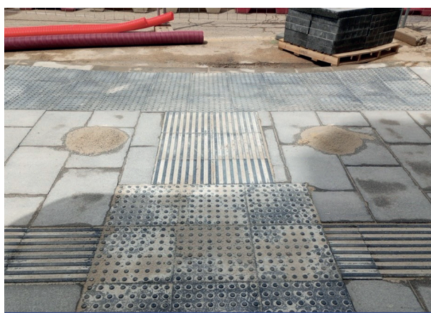
Figura 2. Pavimentación podo-táctil en cruces y pasos de peatones
