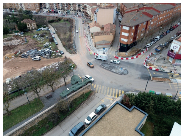
Figura 9. Glorieta C/ La Florida en la N-234
