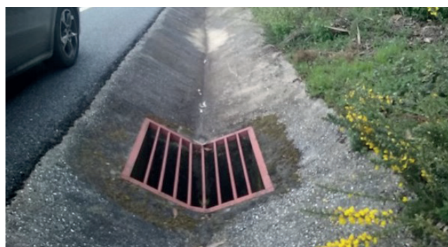
Figura 19. Ejemplo de sumidero con barrotes longitudinales
