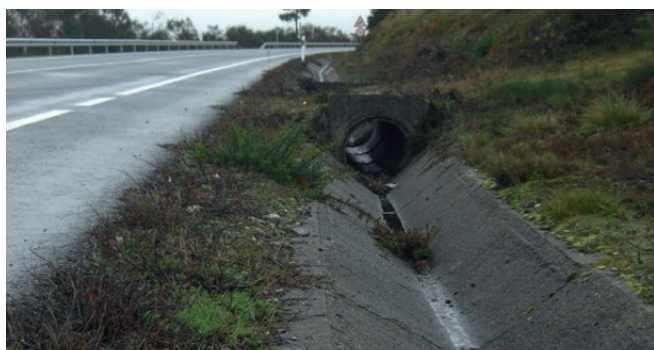
Figura 25. Cuneta triangular con salvacunetas
