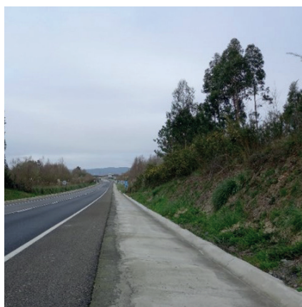
Figura 3. Cuneta de seguridad 10H:1V (después)
