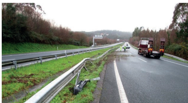
Figura 14. Barrera pegada al arcén. No hay margen a corregir errores
