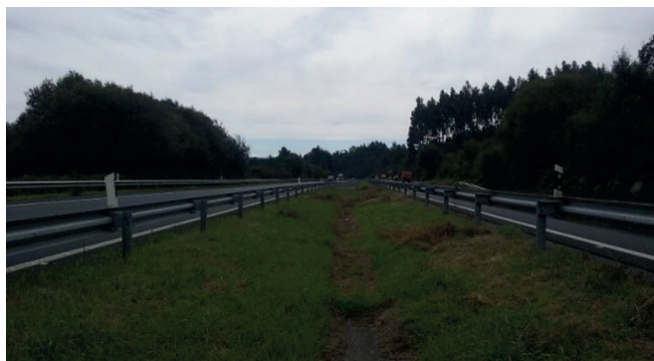
Figura 12. Barrera situada al lado del arcén
