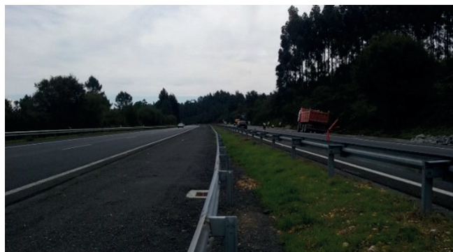
Figura 13. Barrera retranqueada y cuneta de seguridad 10H:1V
