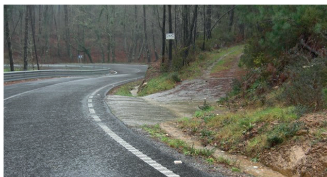
Figura 26. paso vadeable con cuneta de seguridad
