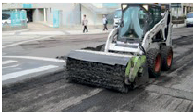
Figura 9. Detalle del barrido de una superficie fresada. Fuente blog Motores y Carreteras
