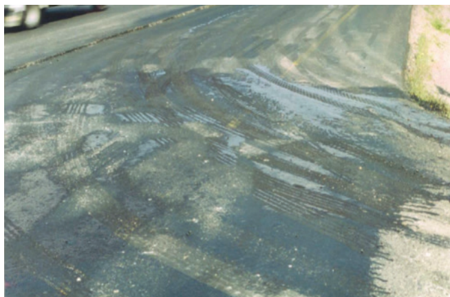
Figura 7. Problemas presentados con emulsiones de adherencia convencionales
