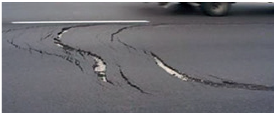
Figura 3. Variación del espesor efectivo de mezcla con el estado de adherencia entre capas.
