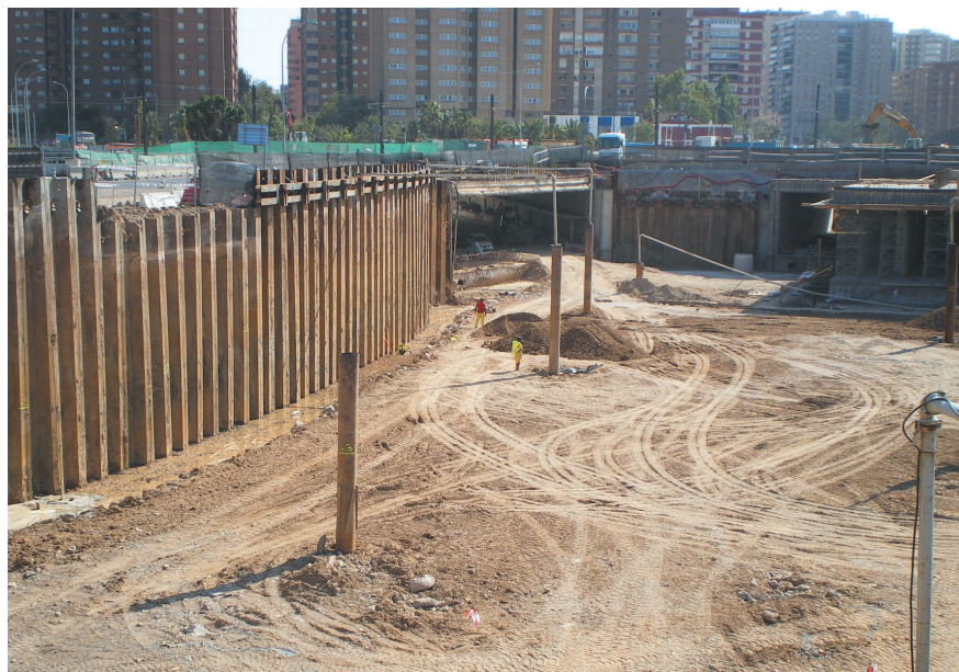
El túnel es un cajón de hormigón armado, y su proceso constructivo ha consistido en conseguir recintos secos mediante un tablestacado de 16 m de profundidad.
