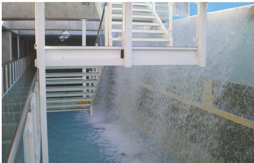
Vista interior en la que se aprecian tanto la pasarela como la cascada.
