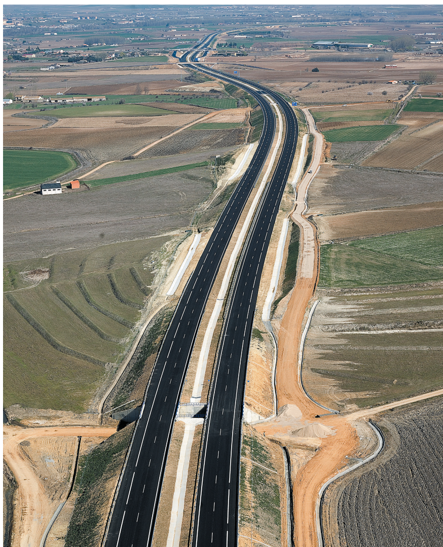
Se han llevado a cabo actuaciones medioambientales como plantaciones, siembras, reposiciones de préstamos, balsas de decantación por un importe cercano a los 2 millones de euros. La foto está tomada en el p.k. 20+200.
