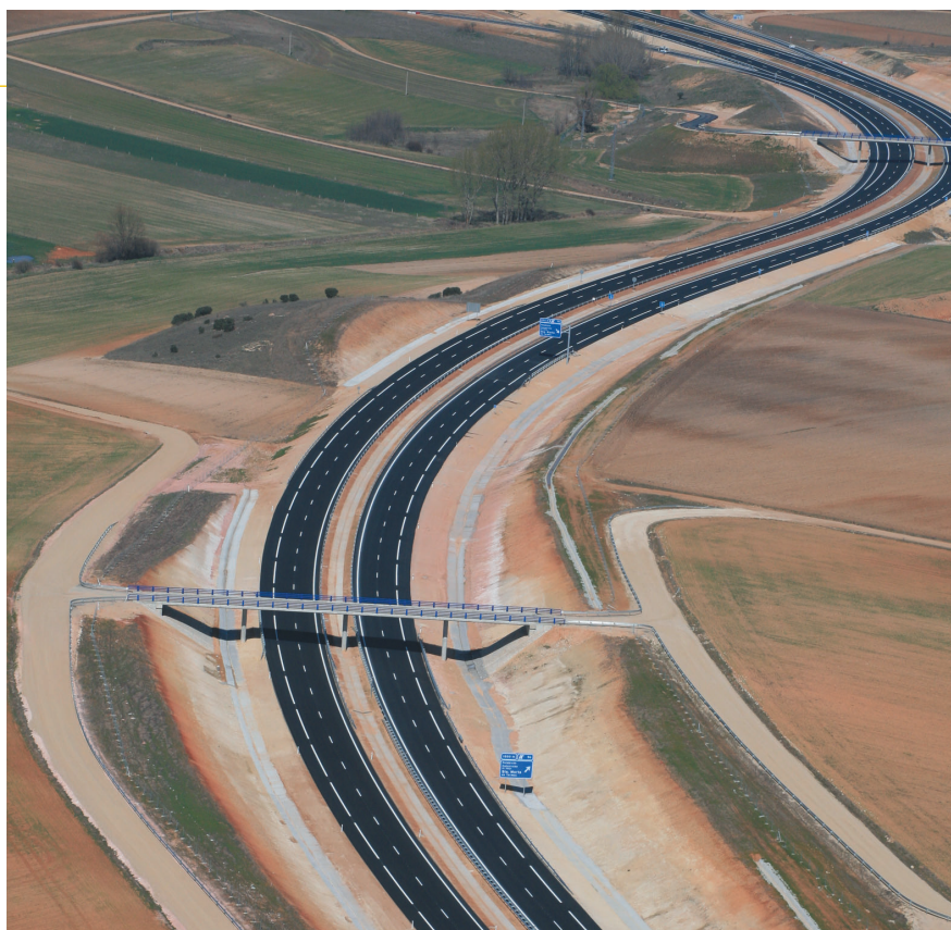
A lo largo del tramo se ha construido un total de 23 estructuras.
