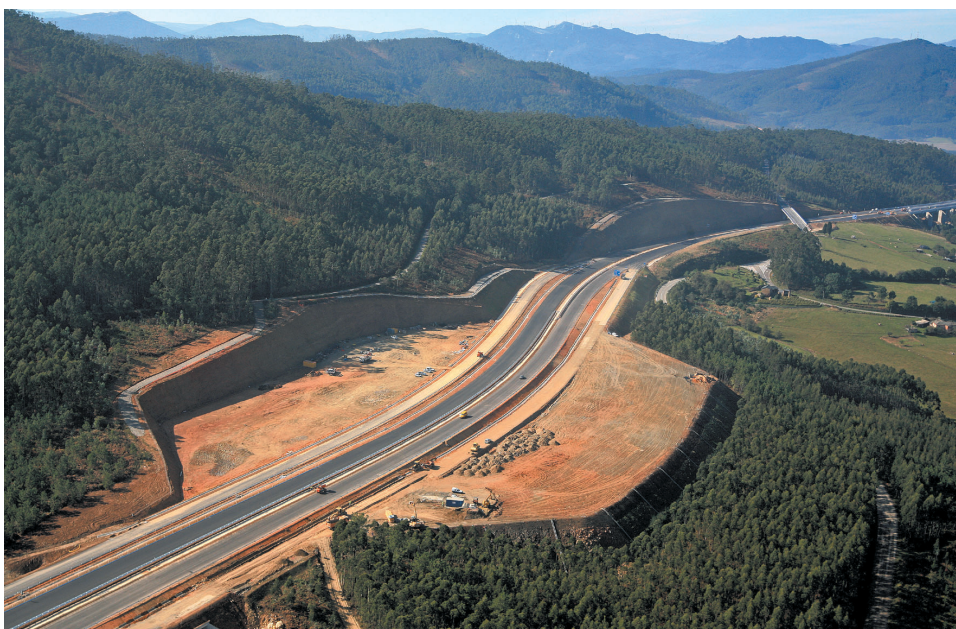
Futura área de servicio de Barreiros.
