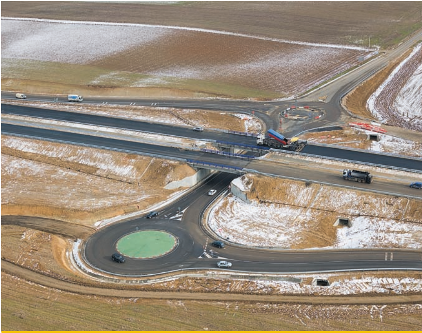
Enlace de Corrales, de tipo diamante con glorietas a ambos lados de la autovía.
