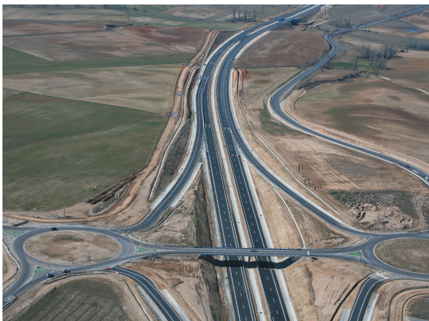
Enlace de Narros del Castillo, de tipo diamante con pesas, que conecta la autovía A-50 con las carreteras N-501, AV-P-627 y AV-800.
