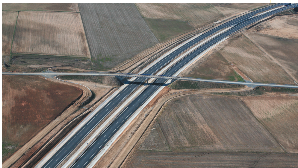
El tramo ha sido diseñado para una velocidad de 120 km/h.
