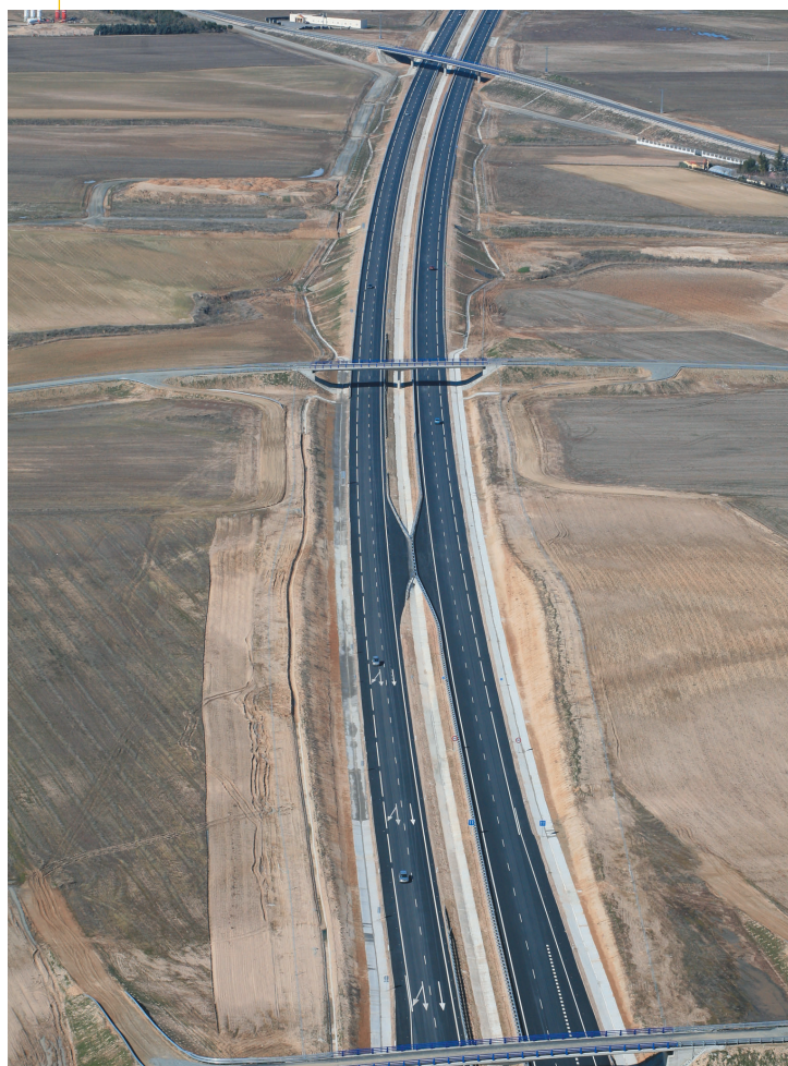
A lo largo del tramo se han dispuesto 10 pasos superiores y 5 inferiores.
