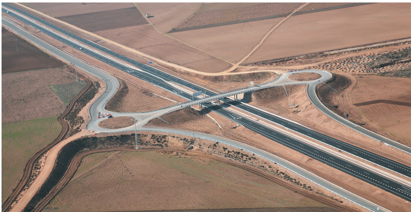
Vista aérea del enlace de pesas y vías de enlace.
