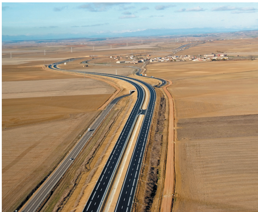
La foto muestra el cruce del nuevo tramo de autovía con la carretera N-611 en el p.k. 7+600.
