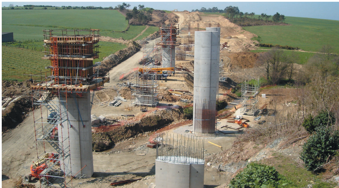
La foto pertenece a la fase de ejecución del viaducto de Frejulfe, situado en el p.k. 3+460.
