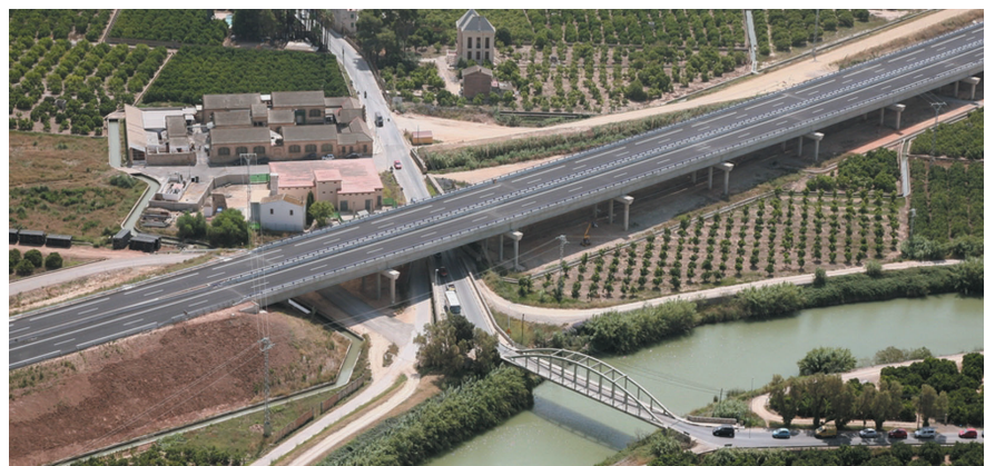
El tramo, de 9 km de longitud, dispone de 2 carriles de 3,5 m de anchura para cada sentido de la circulación.
