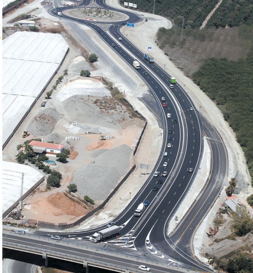
Inicio de la Autovía GR-14, en el enlace con la actual carretera N-340.
