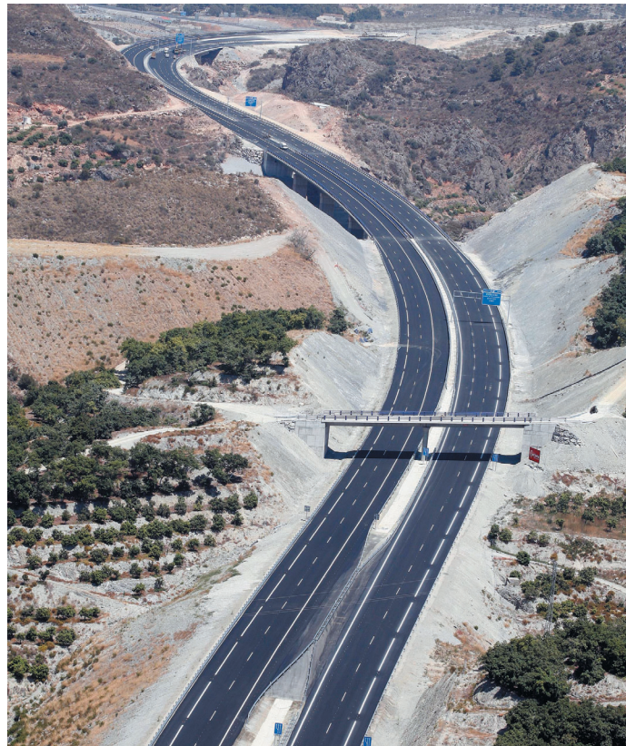
A lo largo del tramo Guadalfeo- La Gorgoracha se han dispuesto 3 pasos superiores y 10 inferiores.
