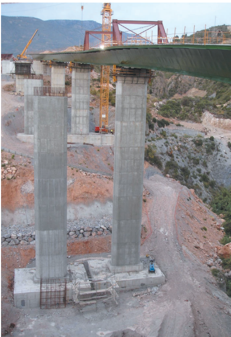
Viaducto de Cañizares: Lanzamiento (izquierda) y vista de la estructura finalizada.
