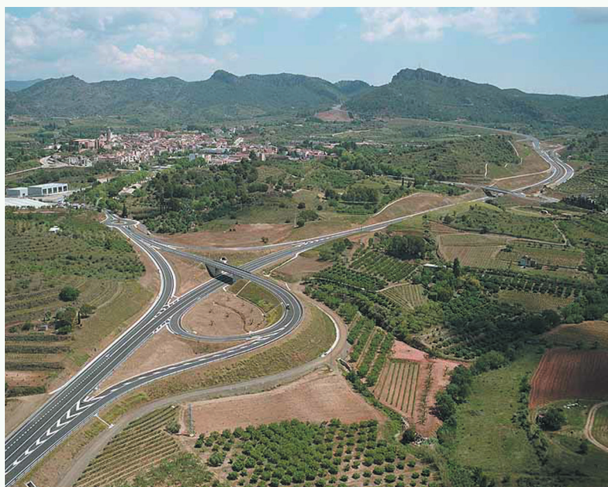
Enlace de Falset Oeste, de tipo trompeta.
