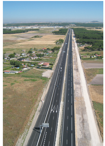
Vista aérea de la A-601 a su paso por el término municipal de Aldeamayor de San Martín, en la provincia de Valladolid (Tramo Norte).
