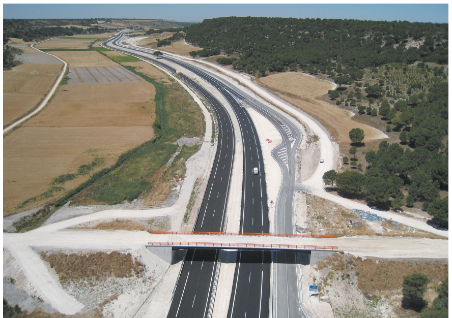
Vista aérea de la A-601 sobre la vía de servicio del Área recreativa de "Los Castillejos" (Tramo Norte).
