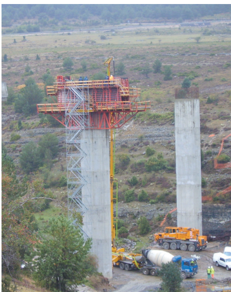
El viaducto del Baranco Hondo tiene una longitud de 210 m y está formado por 7 vanos. A la derecha, vista de las pilas.
