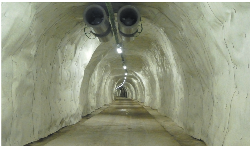
Galería de evacuación.
