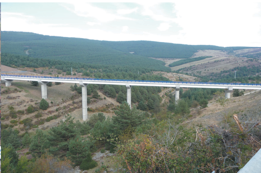
El viaducto del Baranco Hondo tiene una longitud de 210 m y está formado por 7 vanos. A la derecha, vista de las pilas.
