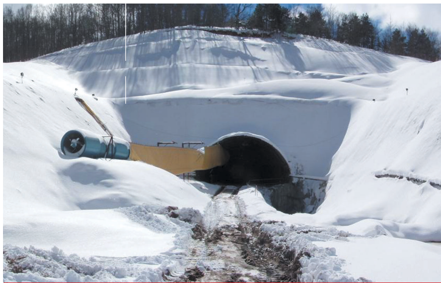
Boca Norte en fase de construcción. Vista también tomada en la época invernal.
