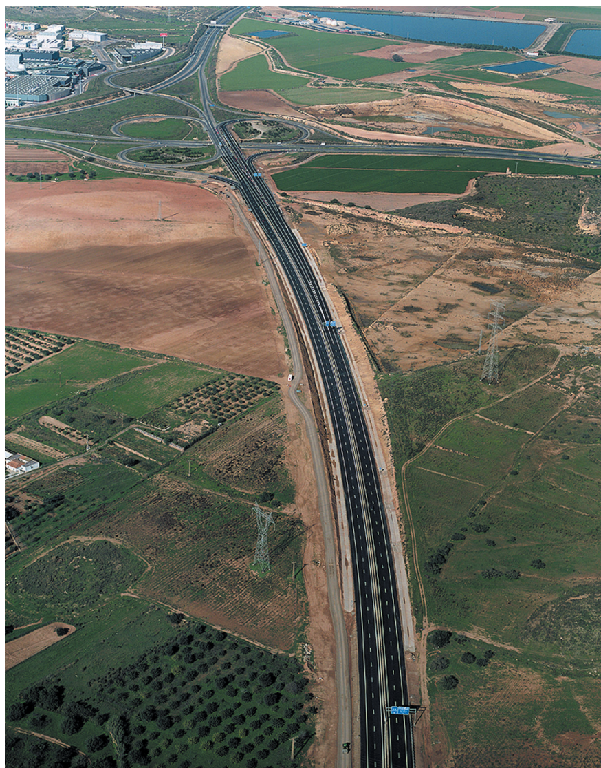
Enlace con la A-30, inicio de la obra.
