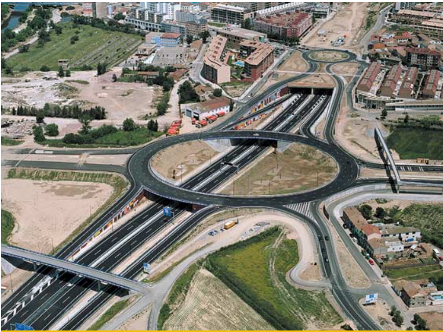
Z-40 (p.k. 5+300). Boca Sur del falso túnel y enlace con la Variante de la N-II.
