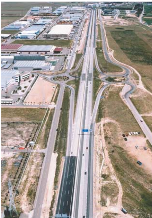
N-330, ampliación con tercer carril.
