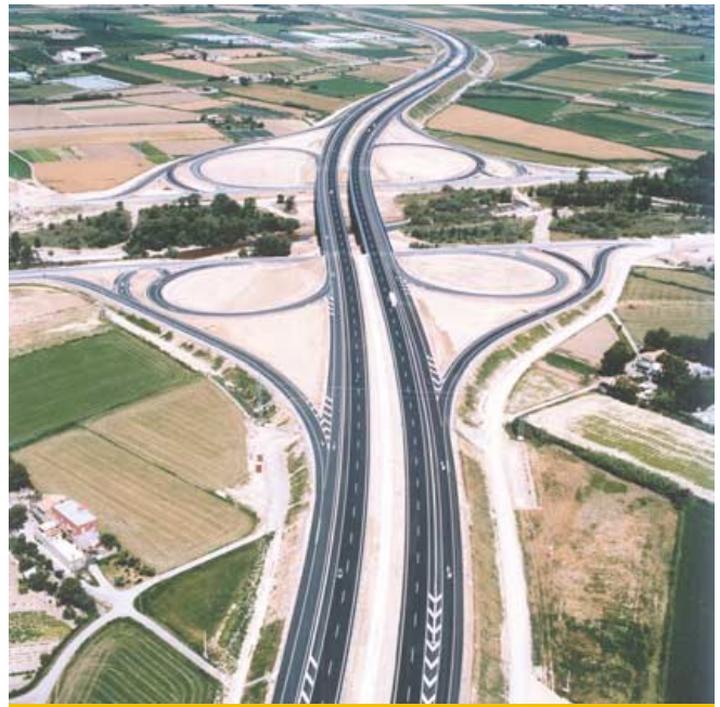
Enlaces y viaducto sobre el río Gállego
