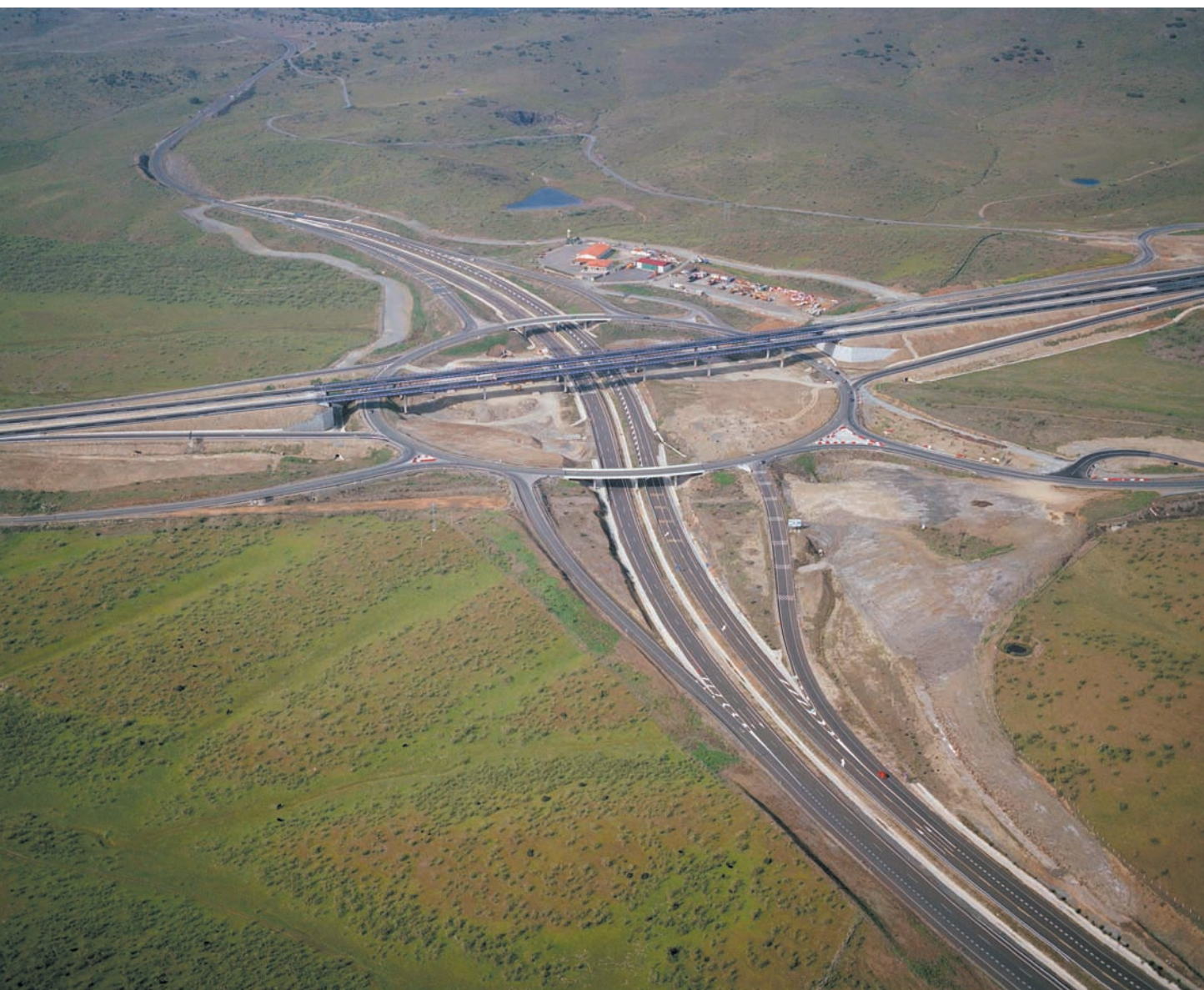
En la imagen, el enlace de conexión de la autovía Ruta de la Plata A-66 con la autovía autonómica EX-A1.
