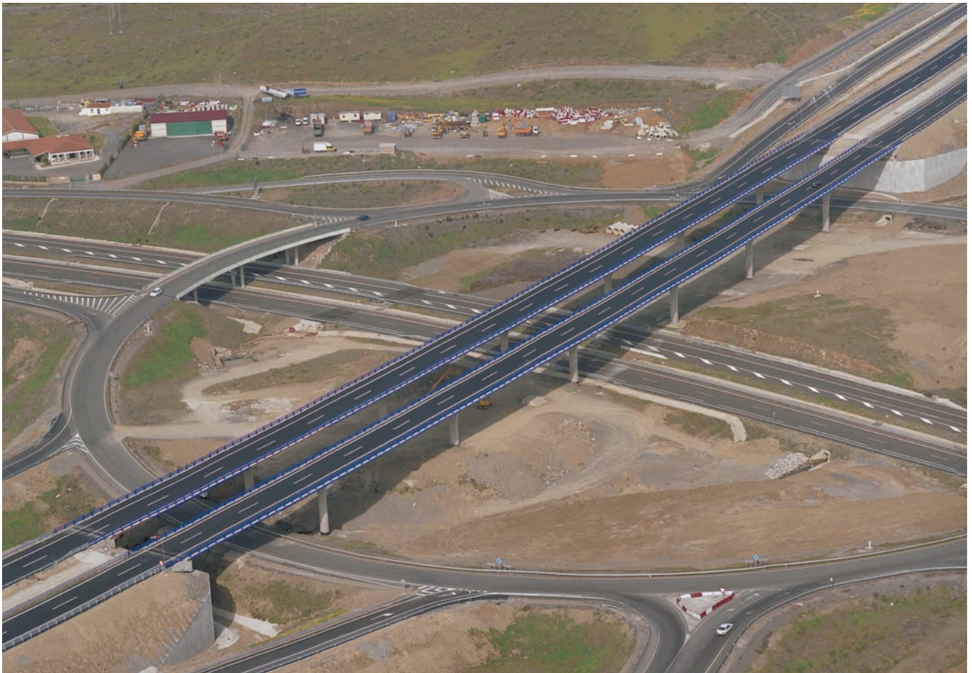
Otra vista parcial del único nudo de este tramo, que supone la conexión simultánea con la autovía autonómica EX-A1, la EX-108 y la N-630. Se trata de un enlace a tres niveles con una gran calzada circular distribuidora en el segundo nivel.
