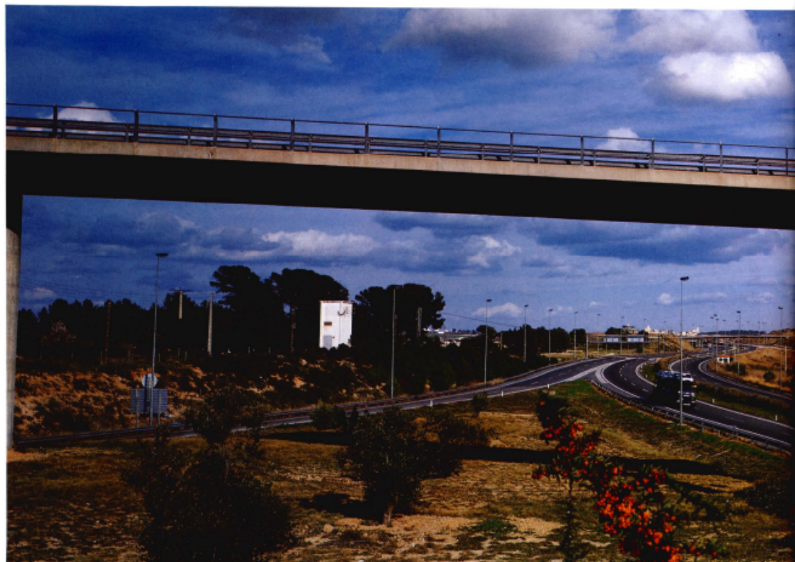
Paso elevado sobre la A-7. Se
