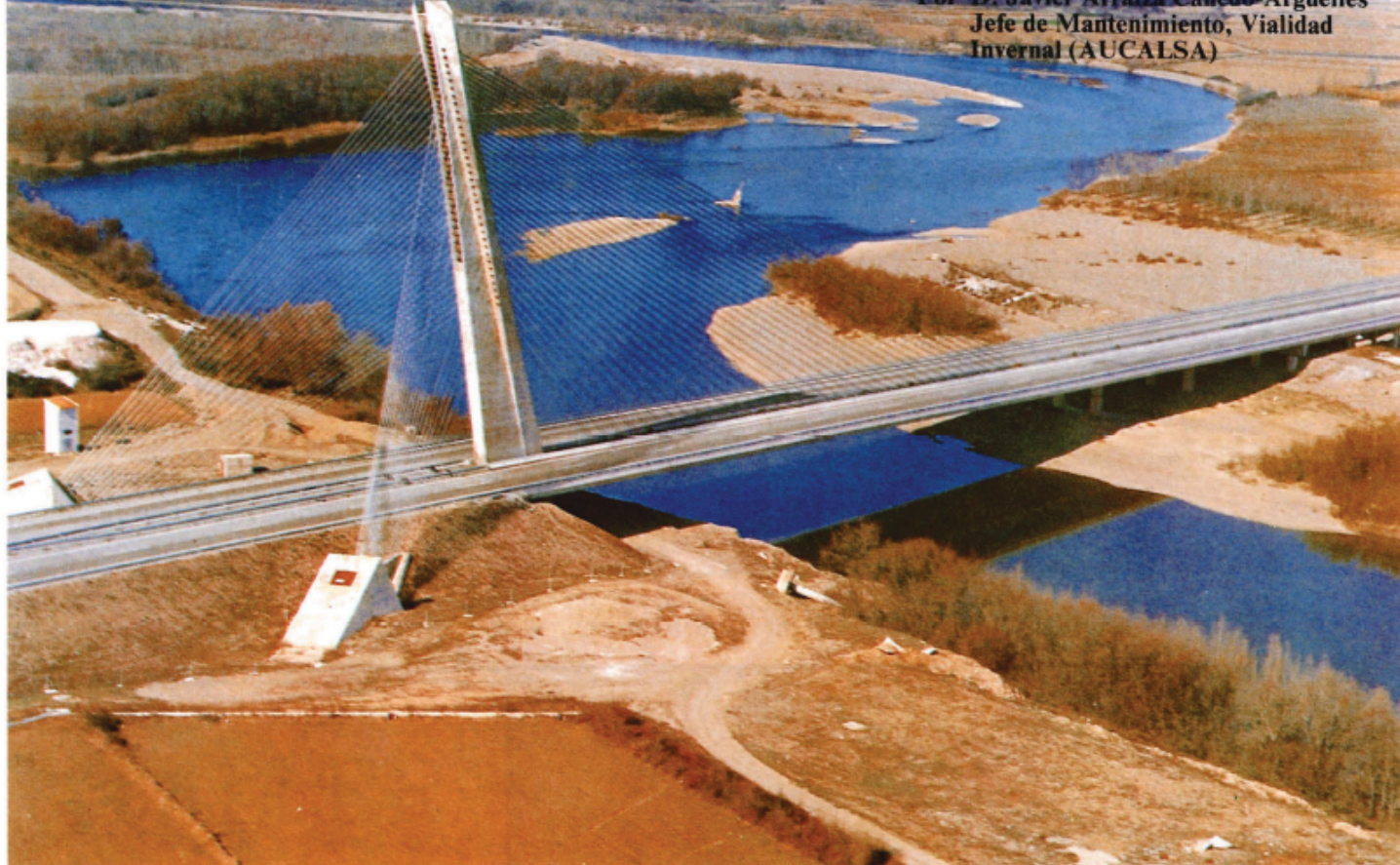
Puente sobre el río Ebro. Vista general
