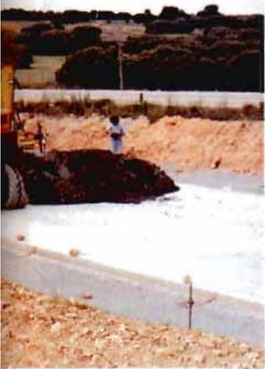
Fijación de los productos filmógenos para el curado del hormigón en obra
