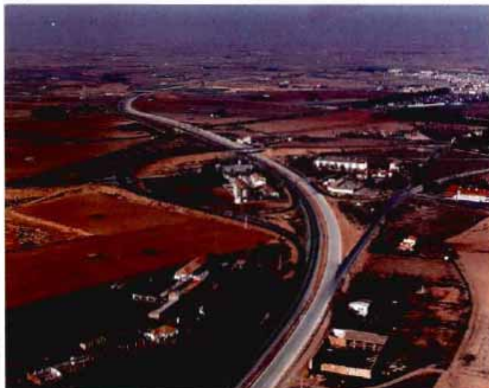
Autovía de Andalucía. Tramo Manzanares - Valdepeñas.
