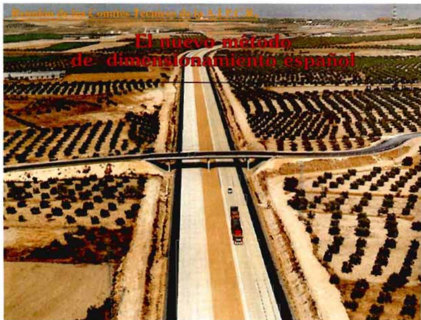
Autovía de Aragón. Tramo de Trijueque.
