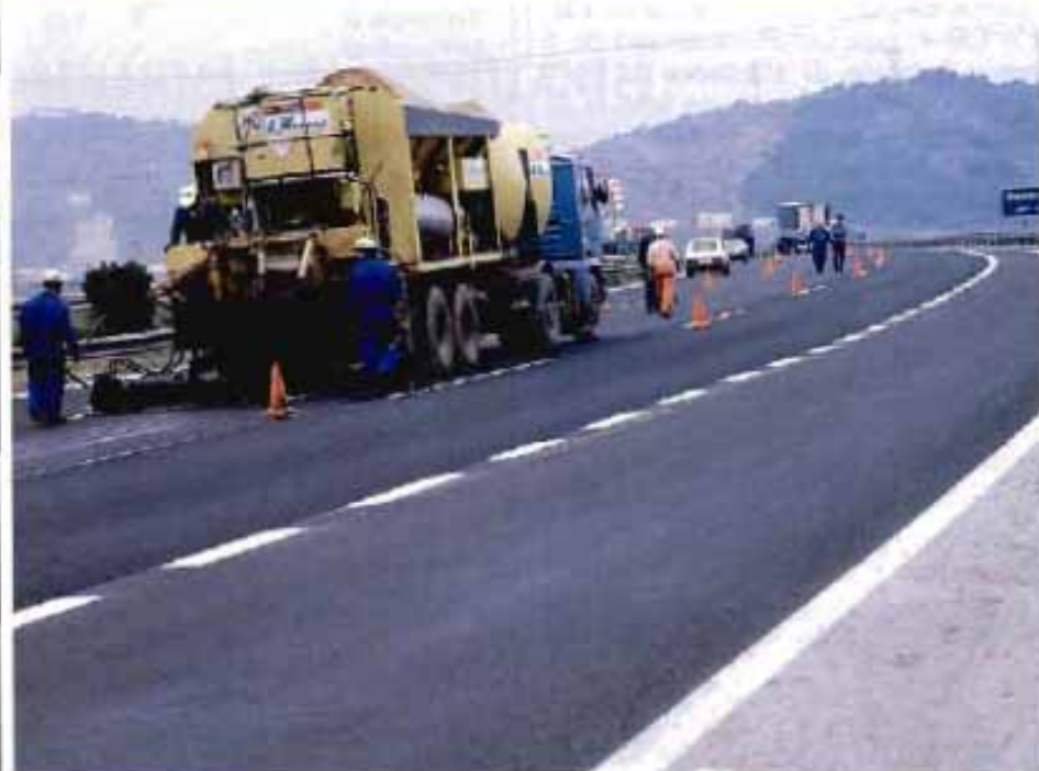
Microaglomerado en Frío en la autopista A-2
