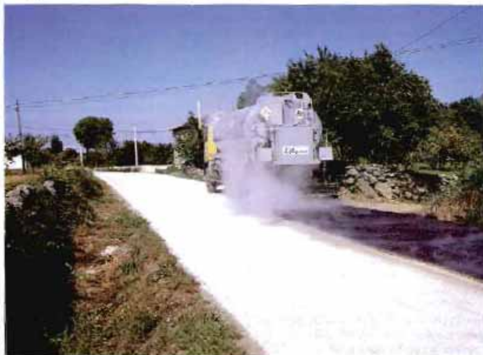
Tratamiento Superficial con Emulsión en Cantabria
