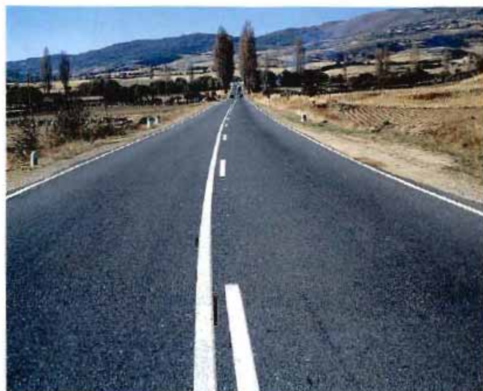
Mezcla Abierta En Frío en Avila C.N.-110.
