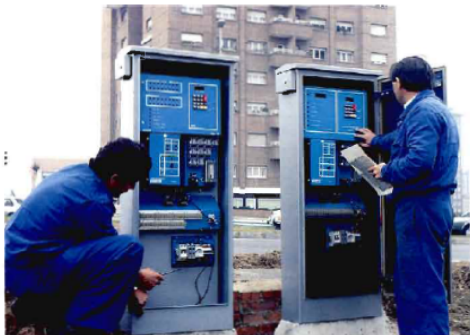
Revisión de postes de control semafórico.
