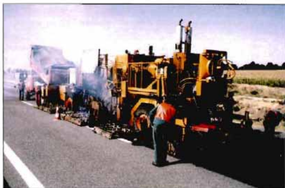
La termorregeneración permite tratar entre tres y cinco centímetros de la superficie del firme.
