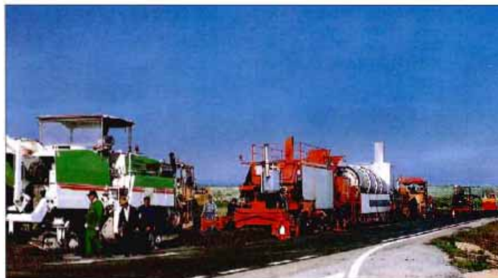
Reciclado en caliente in situ en la N-525, de Benavente a Santiago, tramo Cruce de Mombuey a Padornelo.
