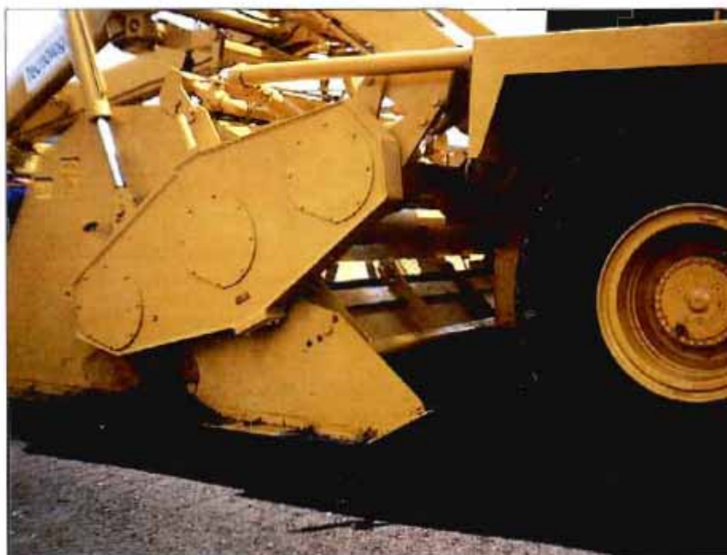
La foto muestra los trabajos de reciclado mixto in situ con emulsión.
