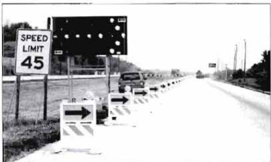
Baliza de zona de obras.
