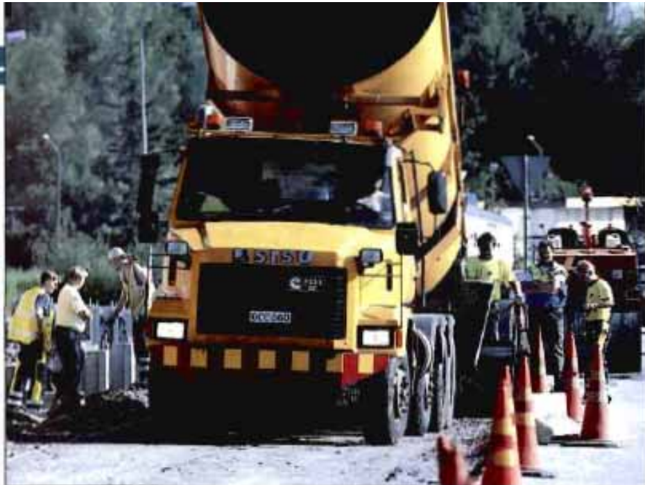
La seguridad en las zonas de obra preocupa cada vez más a los gestores en los países avanzados
