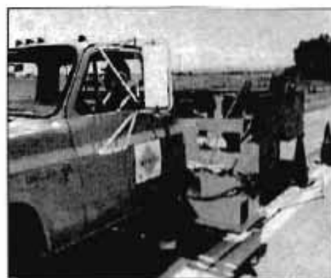
Colocación automática de conos.
