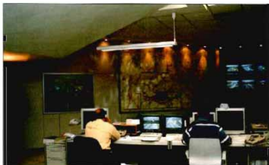
Figura 3. Centro de control.
