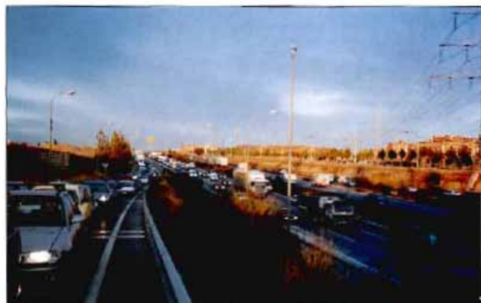
La M-40, con 61 km, se construyó con una sección con tres carriles por calzada.
