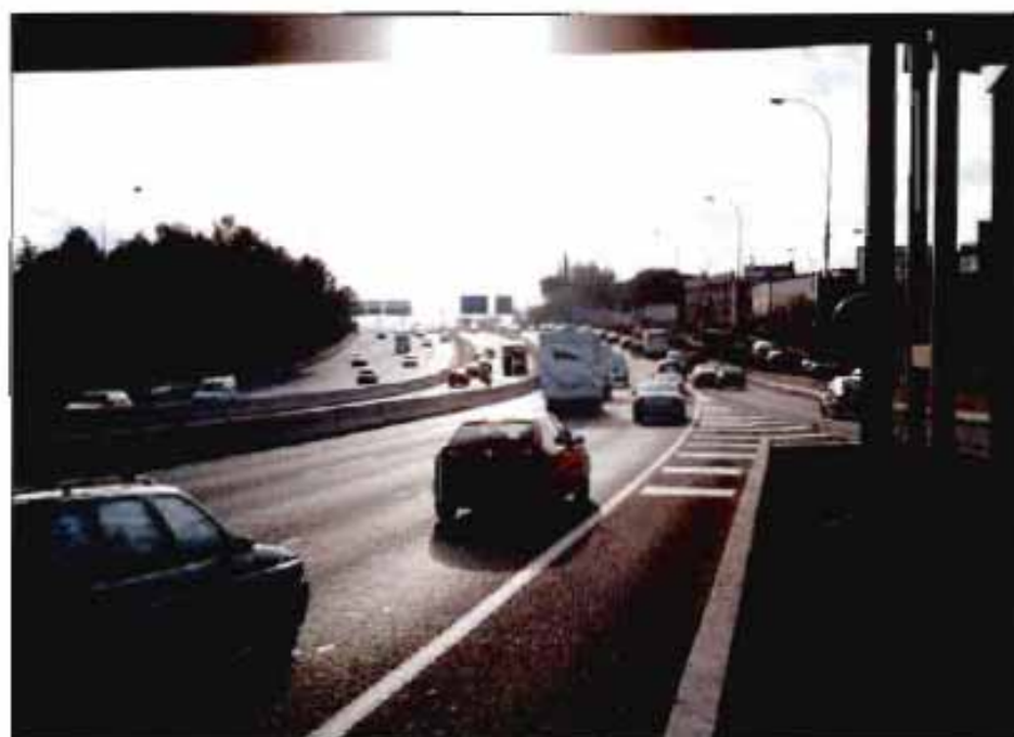
Problemas generados en el entronque de la N-VI con uno de los accesos desde la M-40.
