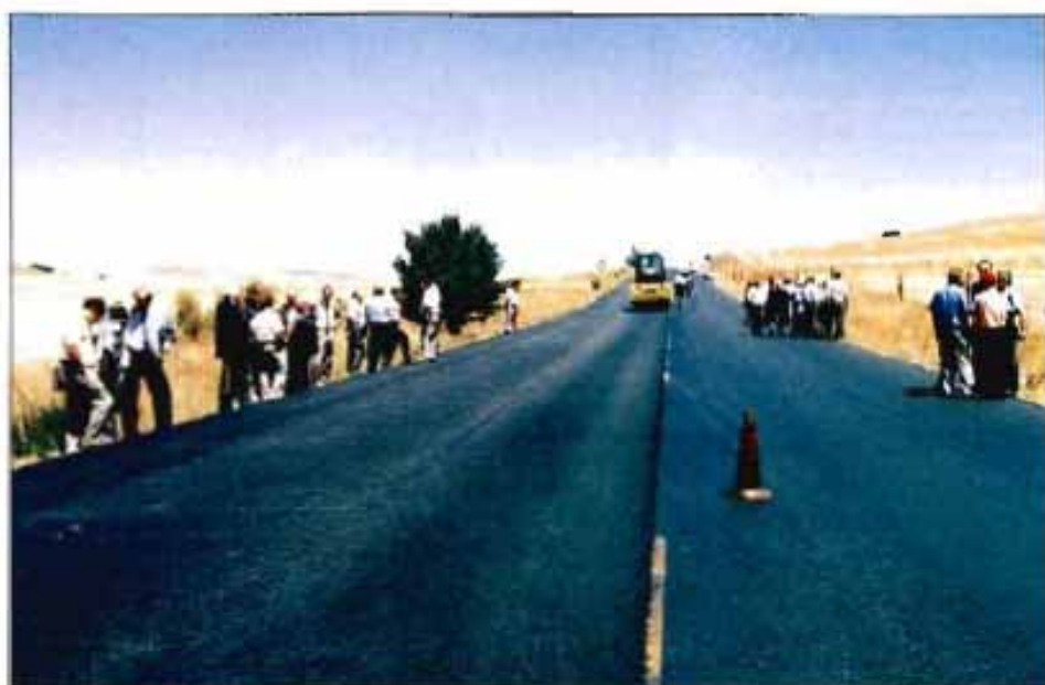
Foto 3. Experiencia llevada a cabo en la M-300 (Madrid) en la que se emplearon distintas modalidades de lechada asfáltica hecha con polvo de caucho.
