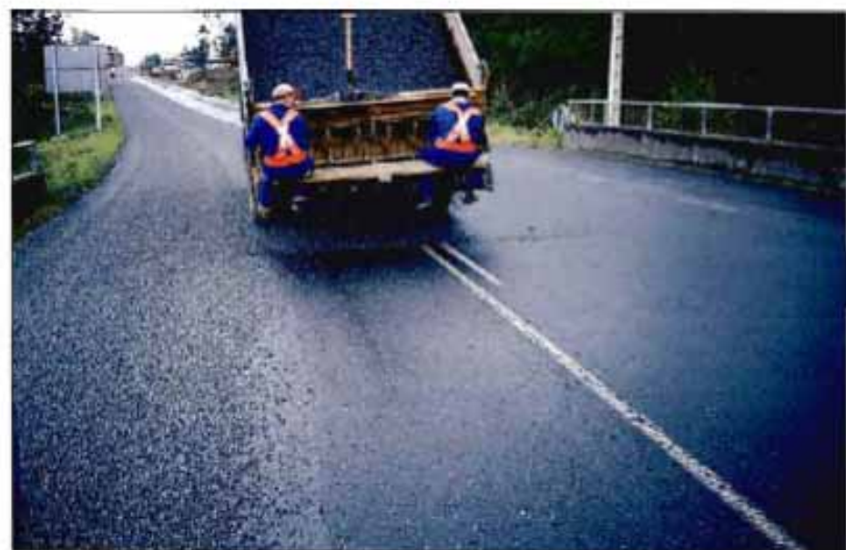
El porcentaje de accidentes es mayor en tramos de macrotexturas bajas. En la foto, extendido de árido grueso en tratamientos tipo "sandwich".
