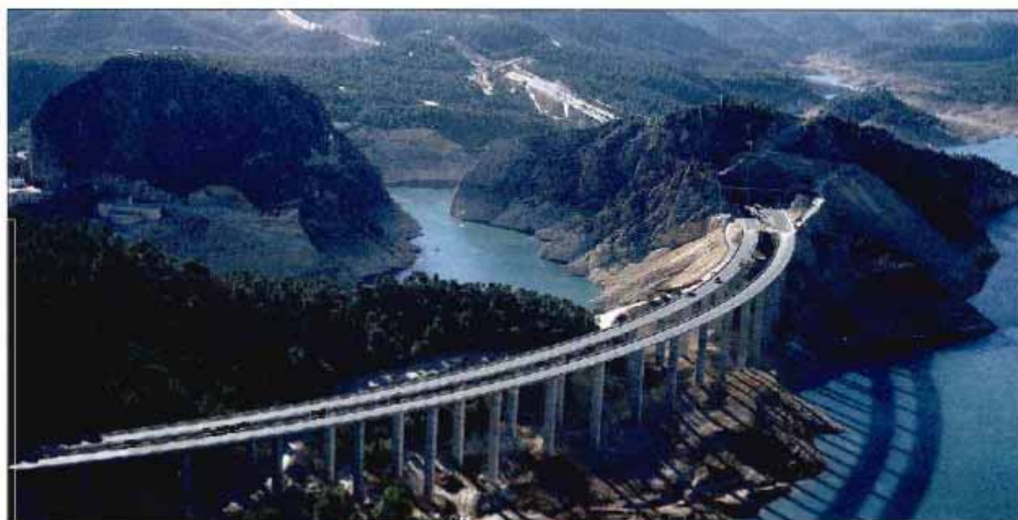
El coste ambiental por el paso de la autovía Madrid-Valencia por la zona del río Cabriel alcanzó el 46% de la inversión.
