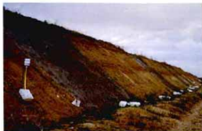
Figura 6: Desmontes con los tratamientos instalados al final del estudio.
